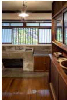
人造石の研ぎ出しでつくられた 芙美子自慢の台所。
